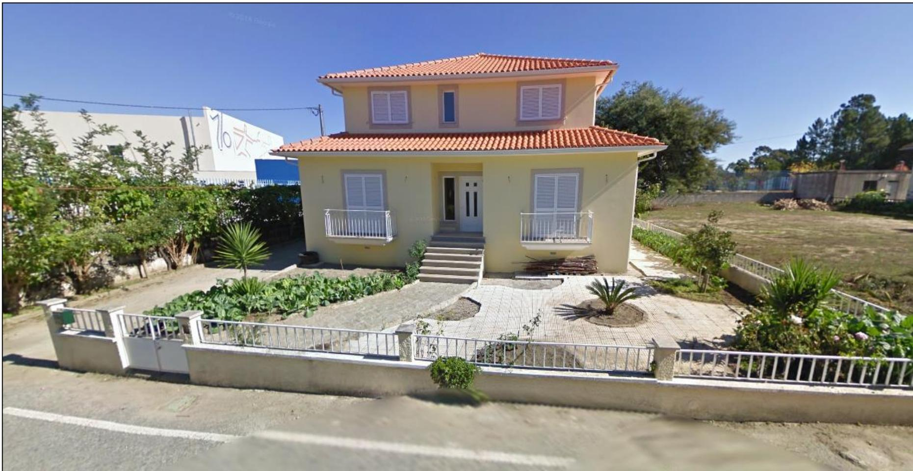
O Edifício 1 é uma moradia de tipo unifamiliar e tipologia T4, com arquitetura tradicional e traça agradável, com construção recente do ano de 2007. A estrutura é em betão armado com lajes aligeiradas. A cobertura é revestida a telha cerâmica. As paredes são em alvenaria de tijolo cerâmico rebocadas estanhadas e pintadas. Apresenta caixilharias em alumínio termolacado. Está murada em seu redor.
