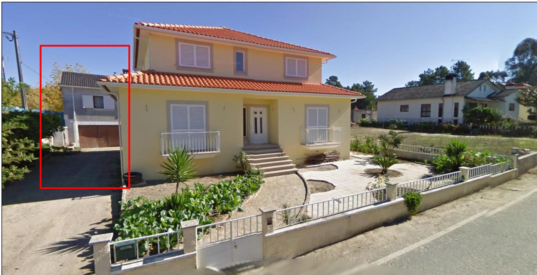
O Edifício 2 encontra-se implantado nas traseiras da moradia. Trata-se de um prédio com idade de 30/35 anos que se está a precisar de pintura geral e interiormente poder-se-á considerar a necessidade de obras de beneficiação. A estrutura é em betão armado com lajes aligeiradas. As paredes são em alvenaria de tijolo cerâmico rebocadas e pintadas. Os pavimentos são revestidos a mosaico cerâmico e parket de madeira.
